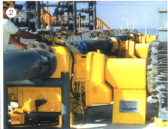
1. Planta de transferencia de petróleo crudo de 30 000 m<sup>3</sup>/día a 40 bar con bombas a doble tornillo.
