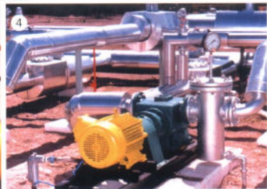
3. Planta de transferencia de crudo con bombas a doble tornillo de 40 m<sup>3</sup>/h a 10 bar.
